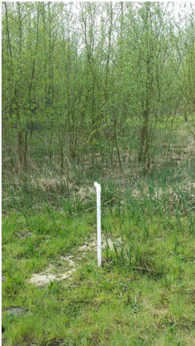
Foto: Monitoringsvoorziening kwetsbaar: peilbuis zonder mantelbuis.
