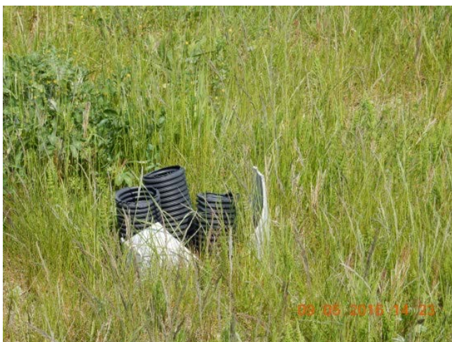
Foto: Mantel om drainageleidingen beschadigd.
